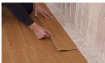
・広い施工現場では、目地ずれが発生することがあります。そのときは、ずれが大きならないうちに、1枚先の最も短いタイルの目地に合わせて貼り固めてから、カンナなどでタイルの大きさを調整し、はめこみます(殺し貼り)。
