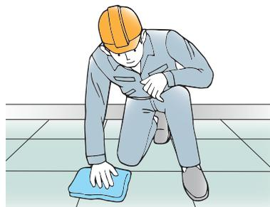
下地に接着剤や油脂類、ワックス、グリス、塗料などの汚れが残っていると、接着不良や汚染の原因になりますので、完全に除去してください。
