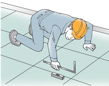
下地は湿度がなく平坦で強度があることが必要です。不陸、目違い、段差、クラック、隙間などが無く平滑に仕上がっているかチェックをし、下地が悪い場合は予め下地補修をしてください。
