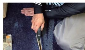
ウィルトンやアキスミンスターの織りカーペットは、必ずジョイント前にジョイント部の地組織の目止めをラテックスで行ってください。また、タフトカーペットの場合でもラテックスによる目止めを行ってください。
