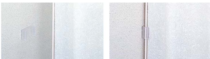
壁にフレーム固定具を取り付けた状態
