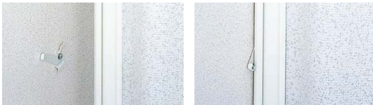
壁にフレーム固定金具を取り付けた状態
